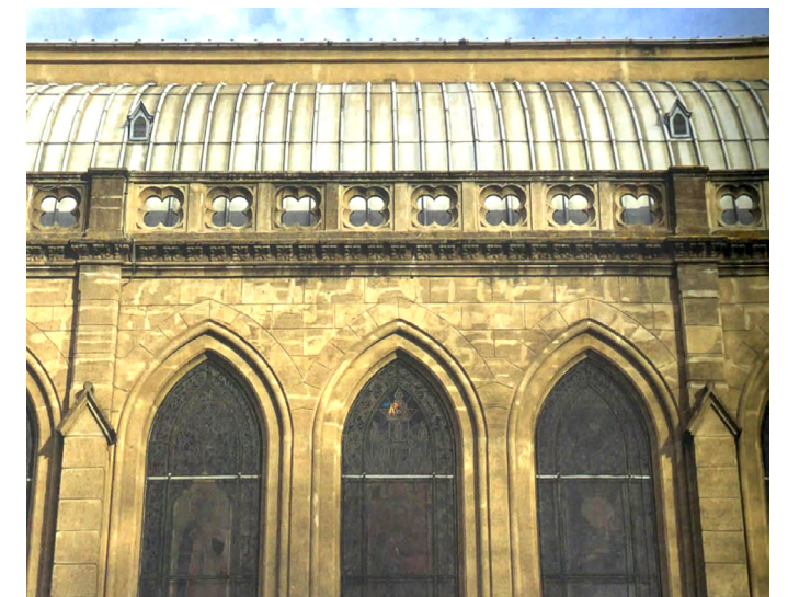
Louis-Auguste Boileau, Église de Sainte-Marguerite , détail des modénatures en béton, Le Vésinet, France, 1862-1865, photographies de Laurent Koetz.
