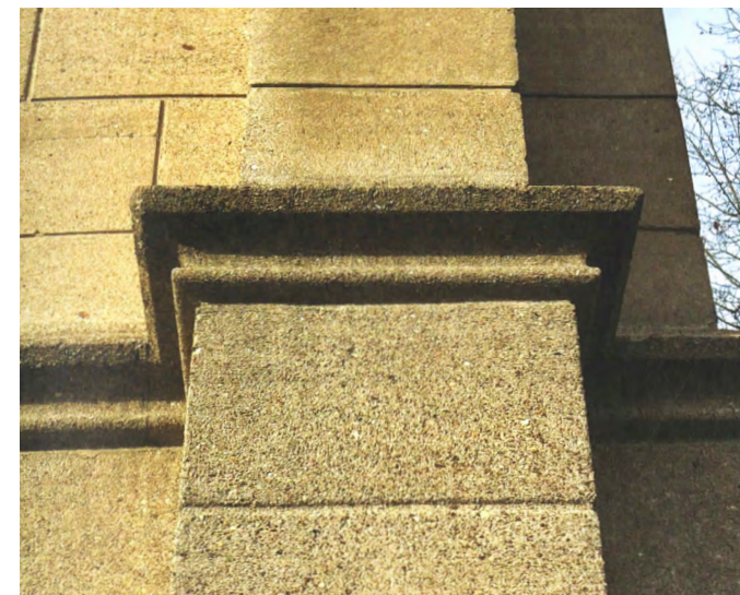
Louis-Auguste Boileau, Église de Sainte-Marguerite , détail des modénatures en béton, Le Vésinet, France, 1862-1865, photographies de Laurent Koetz.
