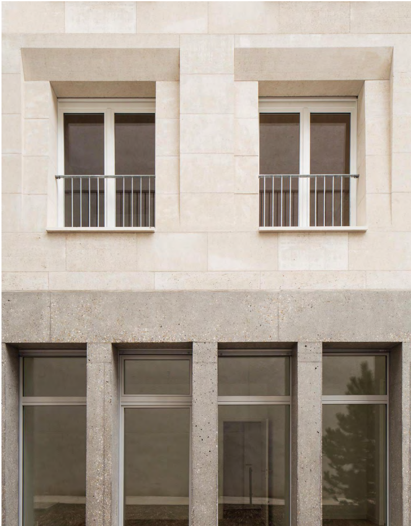
Barrault Pressacco, immeuble de logements rue Oberkampf , Paris, France, 2017. Photographie : © Giaime Meloni.
